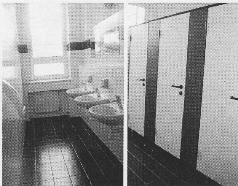
Nové WC na 1. patře.
